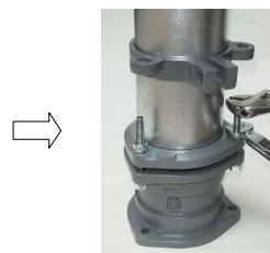
③ 本体用ボルトを挿入し、ワッシャと共にナットを装着し、標準トルクで締め付けます。
